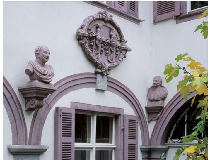
Abb. 29 Balthasar Hüglin. Wappen und Büsten an der Gartenfassade des Brunswilerhauses, Hebelstrasse 15, um 1679–81.
