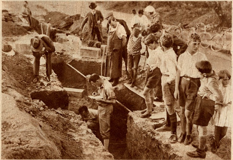
Die Ausgrabungen am Bernerring locken viele Neugierige herbei, die mit großem Interesse die Arbeiten verfolgen
