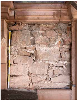
Abbildung 28. Die Fassade besteht aus Sandsteinplatten, die einem Bruchsteinmauerwerk vorgeblendet sind.
