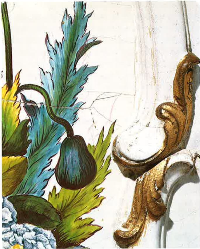
Abbildung 6. Detail aus der Bildplatte der seitlichen Ofenfront (Abbildung 14): neben mechanischen Beschädigungen auch Brandrisse. Spuren von provisorischer Vorzeichnung in Purpur.
